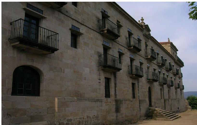
Parte de la fachada este del monasterio (posterior)
