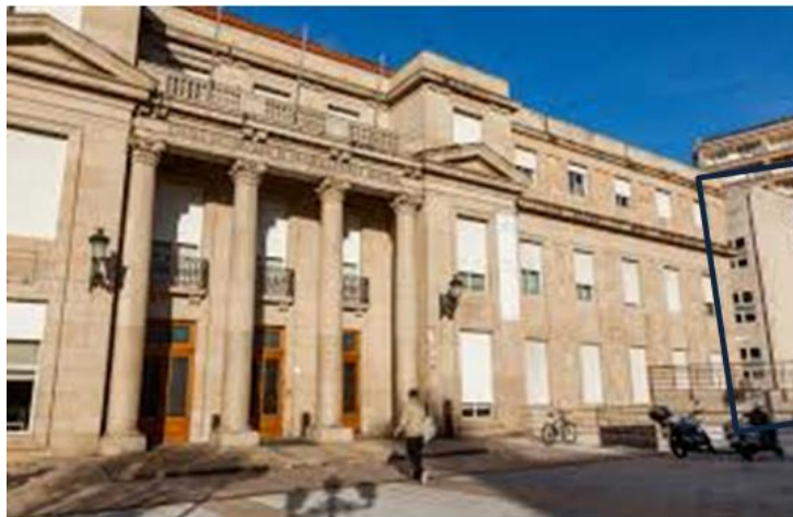
ESCOLA ENXEÑERÍA INDUSTRIAL TORRECEDEIRA, 86
